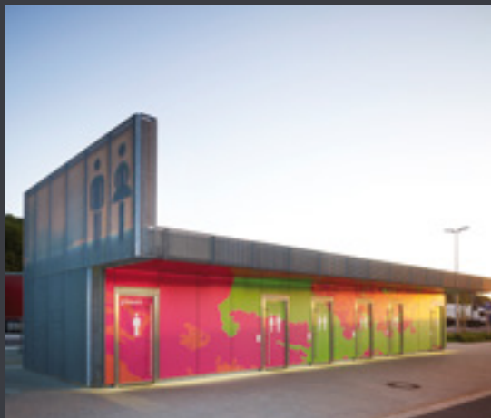
12 RESOPLAN SHOWCASE Parkplatz WC-Anlage, Niedersachsen, Germany
